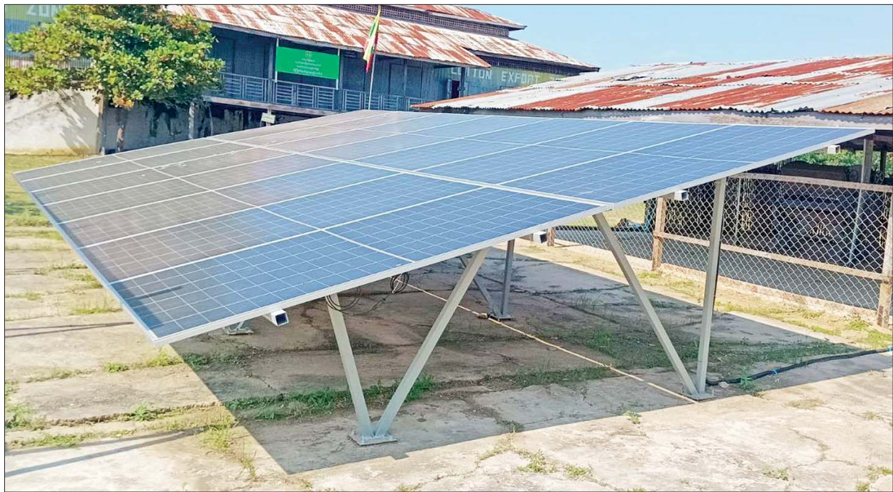
Trina Solar PV - 665 watt ၁၄ ချပ် တပ်ဆင်ထားမှုကို တွေ့ရစဉ်။
